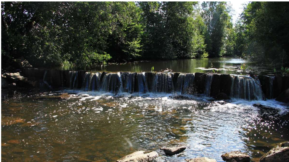
Kuva 6-5. Noin 7 km Lapinjoen suulta ylävirtaanpäin sijoittuva teräsponskipato katkaisee vaellusyhteyden Lapinjoen alaosan koskille.
